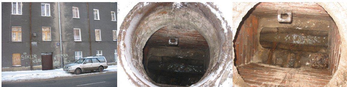
studnia D6a (przy budynku nr 192) – lokalizacja w chodniku, właz typu lekkiego w stanie dobrym, komin i komora studni w dobrym stanie technicznym,
