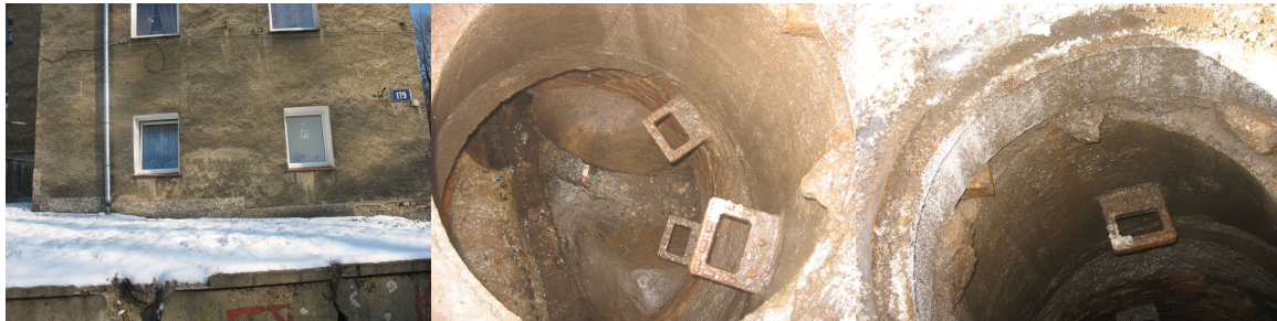
studnia D6a (przy budynku nr 192) – lokalizacja w chodniku, właz typu lekkiego w stanie dobrym, komin i komora studni w dobrym stanie technicznym,
